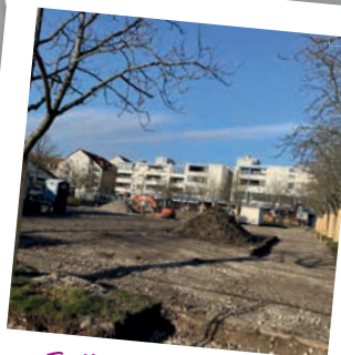
Fertigstellung Plätze der Stadt Ravenaa
